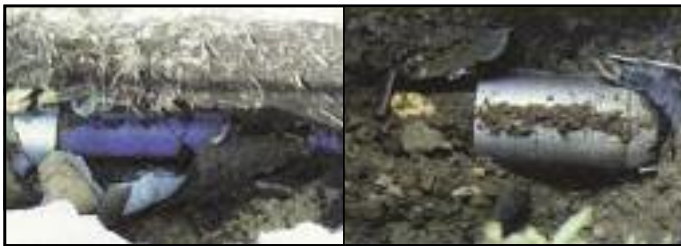
Fig. 8 - Intervento di risanamento con tubi PE 100 blu.
